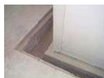
Dettaglio Scavo Excavation example
