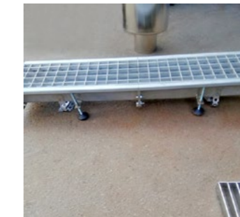
Лоток с базовой полкой, полученной плющением с мембраной
