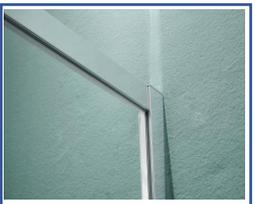
**Регулирующий профиль.** Возможность установки на неровные стены с регулировкой до 20 мм.
