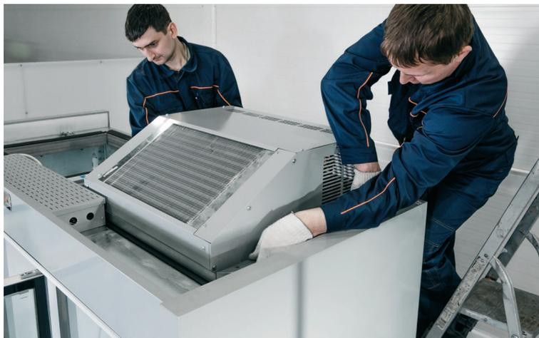
Закрепить агрегат винтами
