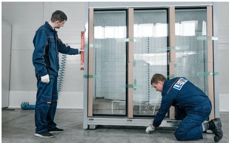
Регулировку шкафа по высоте производить при помощи регулируемых опор, установленных на нижних направляющих
