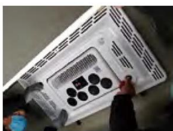
4. Закрепить кондиционер крепёжным швеллером, закрыть облицовочной рамкой
