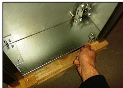
**-ОТВЕРНУТЬ ИХ ГАЕЧНЫМ КЛЮЧОМ НА 13**
